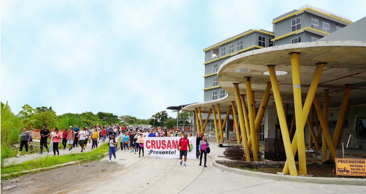
Edificación del Crusam en etapa final de construcción.
