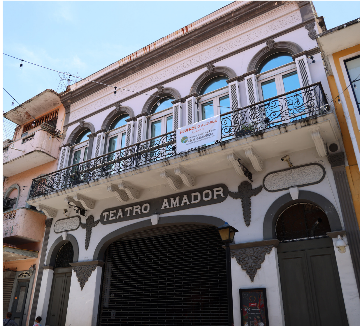
Estructura remodelada del antiguo Teatro Amador.
