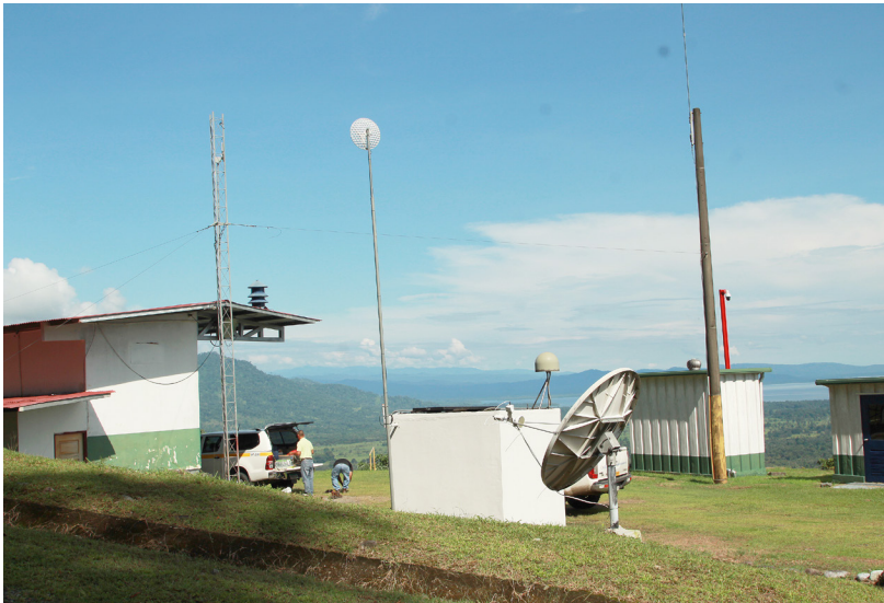
Los técnicos en la estación de Chiriquí Grande realizan mantenimiento preventivo y correctivo. Foto: John Abrego
