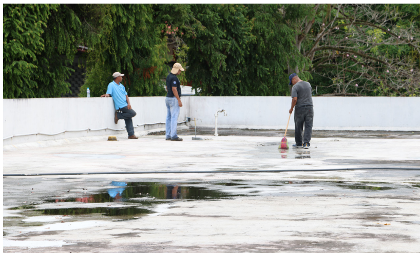
Personal de mantenimiento realiza limpieza en la azotea de la facultad.
