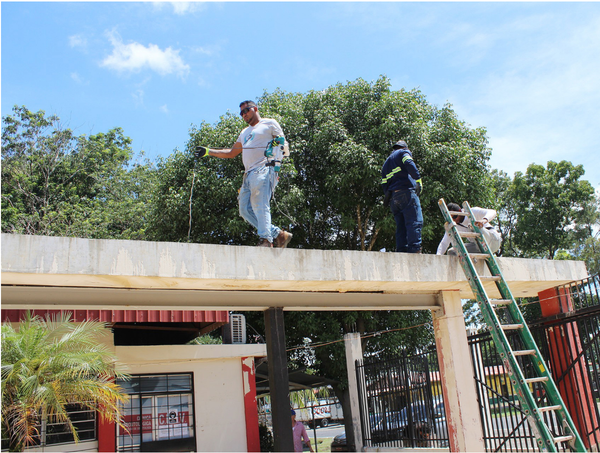
Trabajadores de cuadrillas especiales de la Rectoría colocan techos de termopanel.
