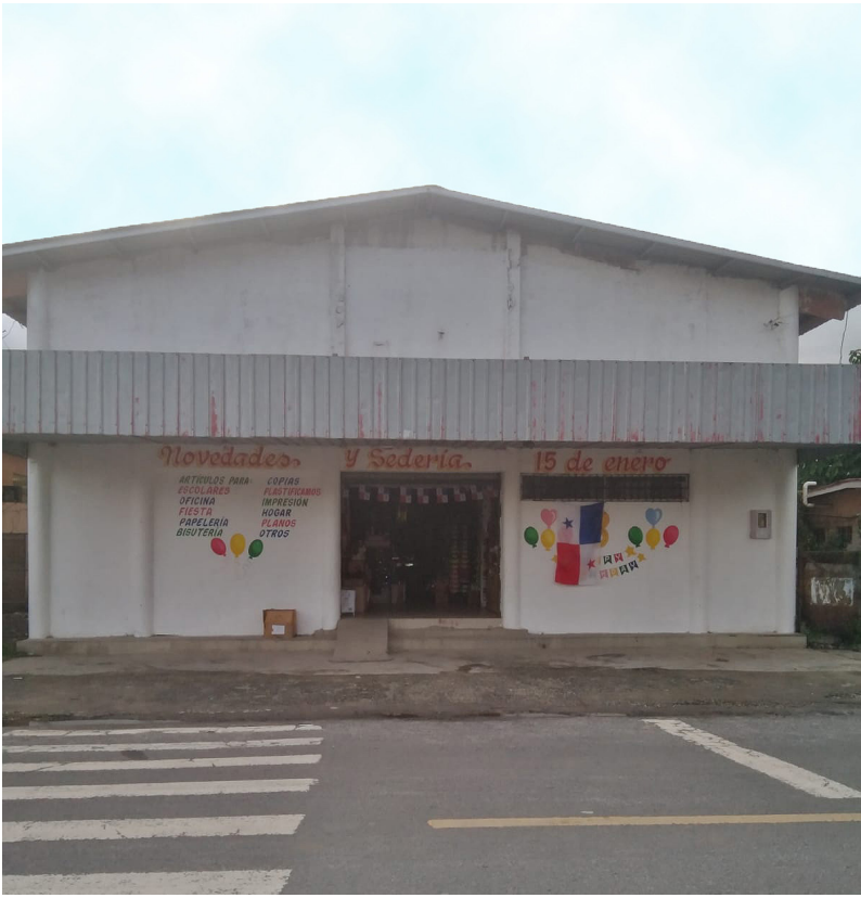
Antigua instalación del Cine Fidelia en Antón.
