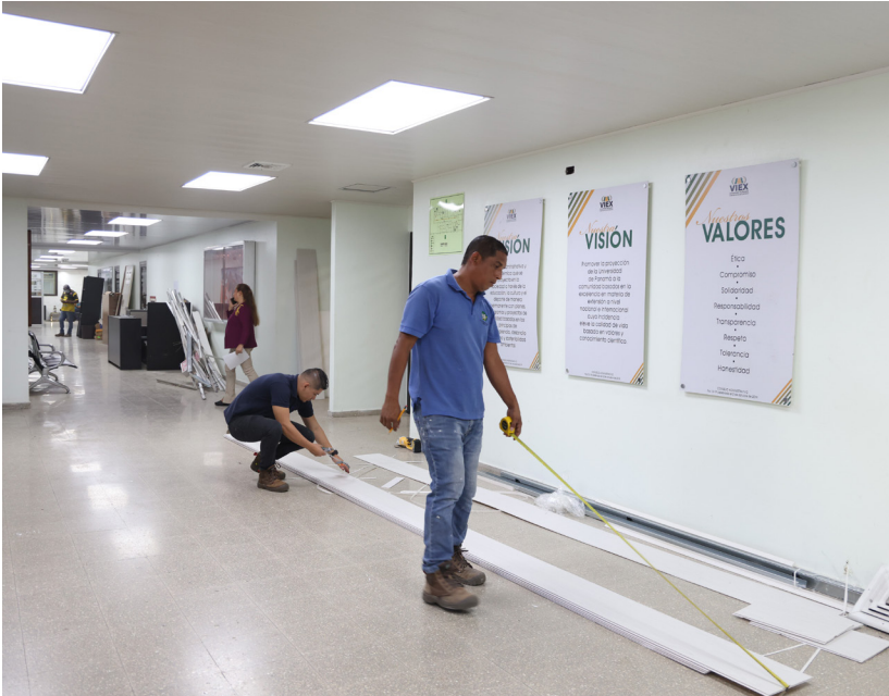
Personal de Mantenimiento cambia cielo raso tipo PVC.
