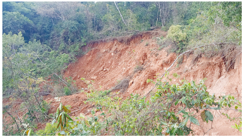
Desprendimiento de tierra en Rancho Café, Cerro Azul. Foto: Oliver Martínez
