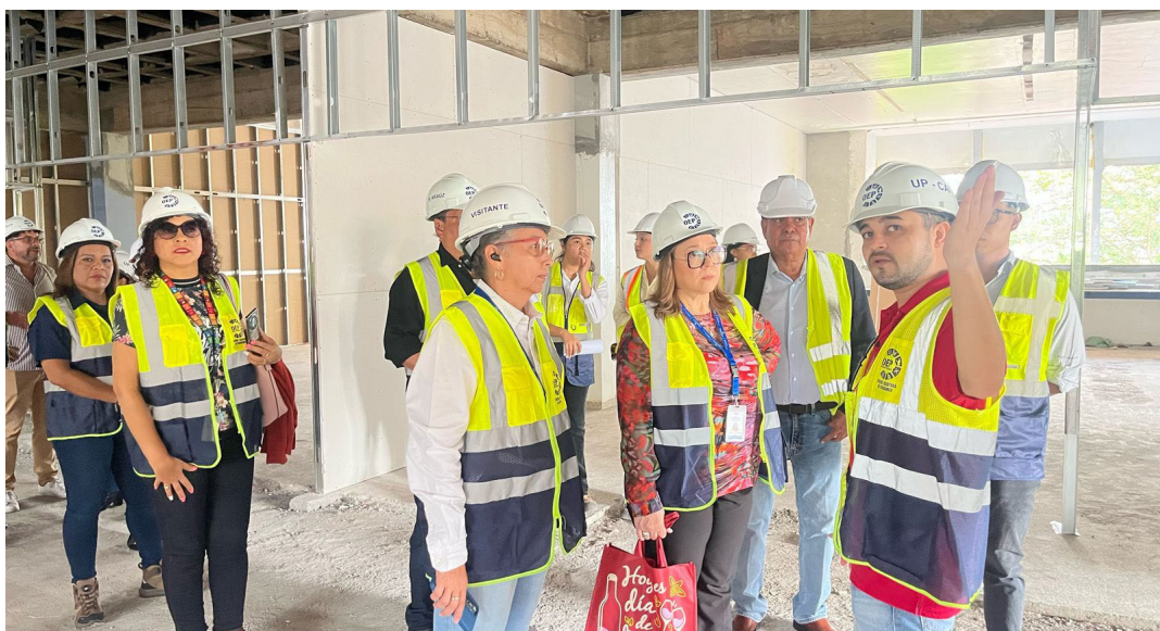
El Ing. Eric Jaén explica al vicerrector Administrativo, Arnold Muñoz, directivos del MEF y el Meduca, los trabajos que se han venido realizando a lo interno del edificio de Biología de la Facinet.
