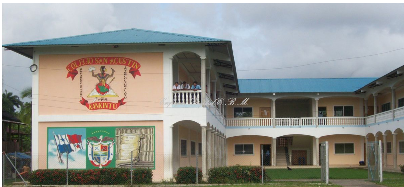
Instalaciones del Programa Anexo Universitario de Kankintú.
