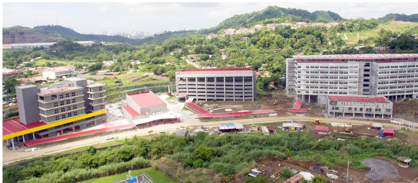
Foto de archivo de cada etapa de la construcción de las nuevas instalaciones del Crusam.
